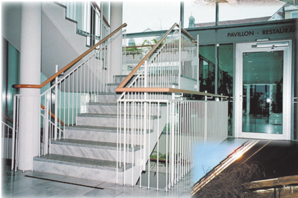
Geländer- und Treppenbau
