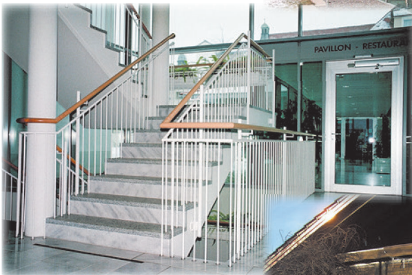
Geländer- und Treppenbau
